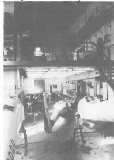
Die Werkstatt mit Zwischendecke im Betrieb
