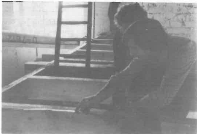
Beim Bau der Zwischendecke
