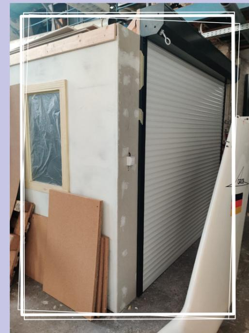
Der Bau der Umhausung für die CNC-Fräse wurde ebenfalls mit der Installation der Elektrik, d.h. konkret von Lichtern und einer Steckdose, eines Rollltores sowie einer Absaugung beendet. Der Fokus wird nun mehr auf eine effizientere Absaugung gesetzt, mit der im Anschluss dann neue Außenflächen-Formen für die B13e aus Ureol gefräst werden kann. Die jährliche Flugzeugwartung verlief ähnlich wie jedes Jahr. Lehrreich und mit vielen Höhen und Tiefen.
